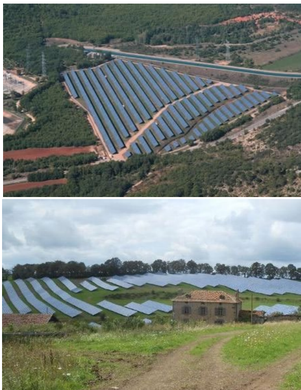
Photo 4 : A gauche, centrale photovoltaïque sur la commune de Jussac - La Montagne. A droite, centrale photovoltaïque sur la commune d'Arpajon-sur-Cère – La Montagne.
