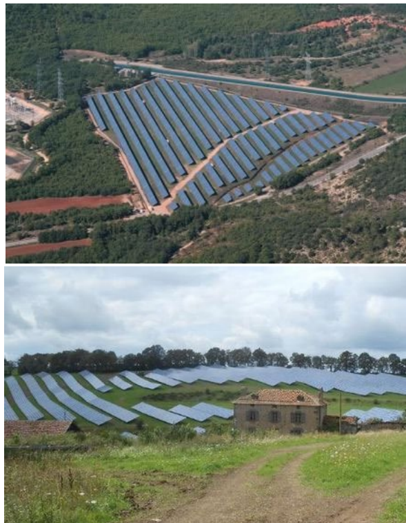
Photo 4 : A gauche, centrale photovoltaïque sur la commune de Jussac - La Montagne. A droite, centrale photovoltaïque sur la commune d'Arpajon-sur-Cère – La Montagne.
